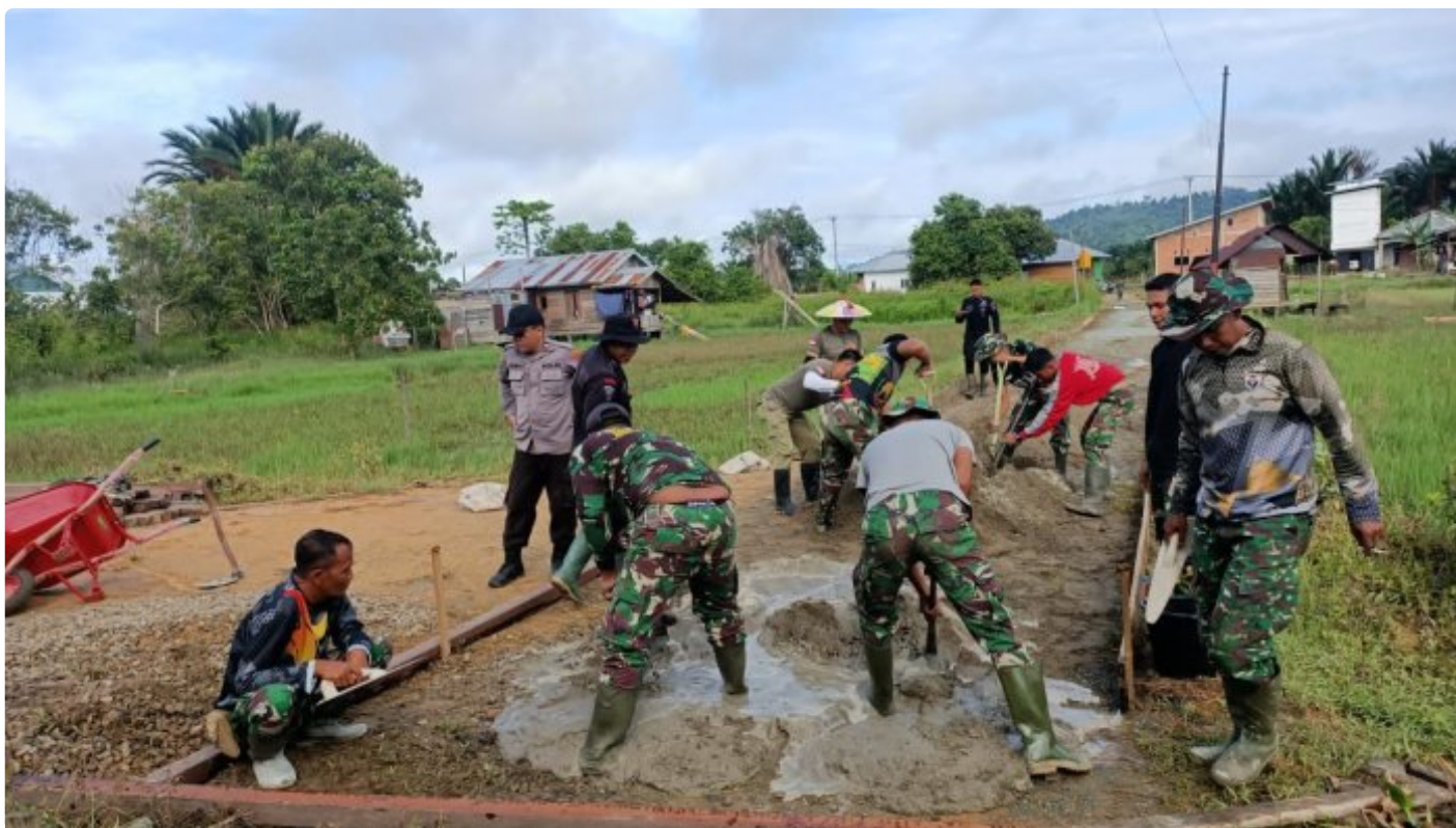
Kompak, Satgas TMMD ke- 118 Bareng Warga Semenisasi Jalan di Desa Malinau Sebrang
